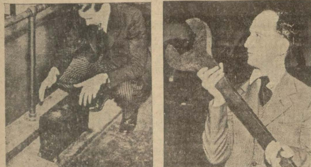
Saatin makine dairesi daima bir sıcaklıkta bulundurulur, bunun içinde kalorifer kullanılır. Bu muazzam İngiliz anahtarı ile (Big Ben) saati ayar edilir, vidaları sıkıştırılır.
